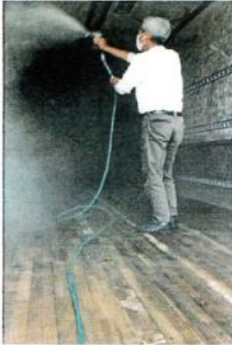
天井、壁面へ噴霧
